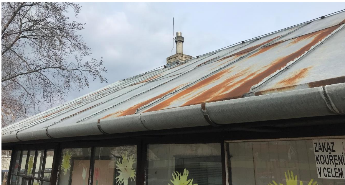
Komínové těleso – azbestocementová roura nad střechou
